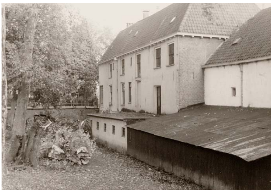
Afbeelding 9 en 10: een blik op de bebouwing langs de Binnengracht alias Moddersloot ter hoogte van de Walstraat. De kleine aanbouwseltjes horen tot de bedrijfspanden van de ijzerwarenhandel van Dullaert. Op de onderste foto is het hoofdgebouw Spitaalstraat 2 te zien, tegen de nog bestaande brug over de gracht.
